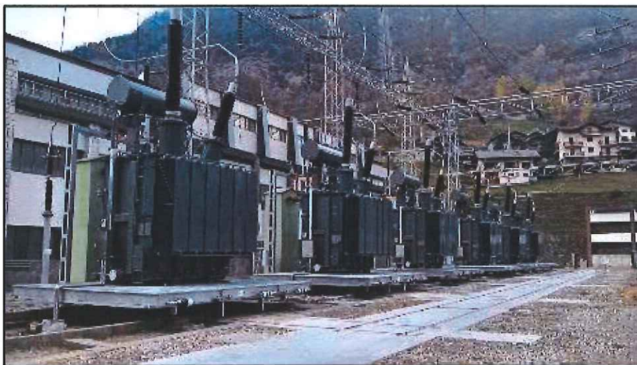
Vista a lavori ultimati
