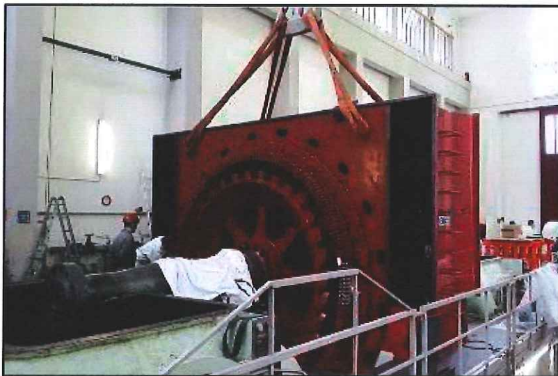
Zuino - Posizionamento semistatore superiore in centrale
