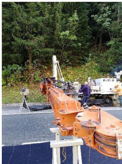
Sonda utilizzata per indagare l'imbocco di monte della galleria di derivazione (Lunghezza foro 200 metri)
