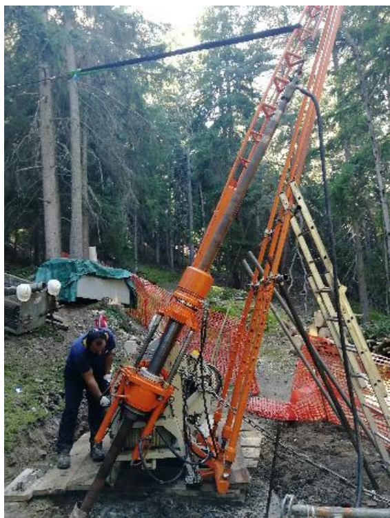
Sondaggio in zona vasca di carico
