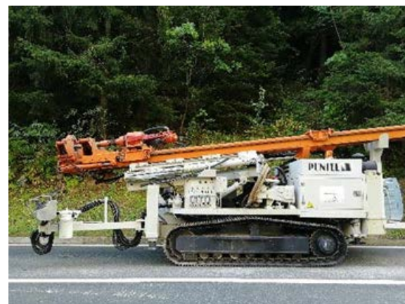
Sonda utilizzata per indagare l'imbocco di monte della galleria di derivazione (Lunghezza foro 200 metri).
