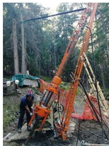
Sondaggio in zona vasca di carico.
