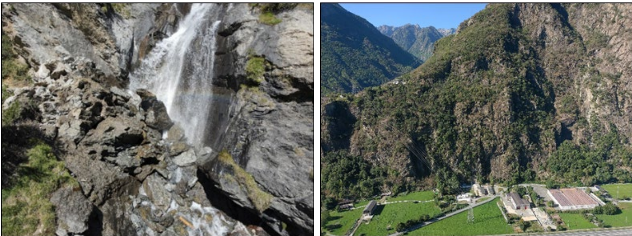
Lungo il canale di Chavonne ramo La Nouva, nel 2022, sono stati definiti degli interventi di mitigazione dal rischio caduta massi che potrebbero interessare il sedime del canale.
